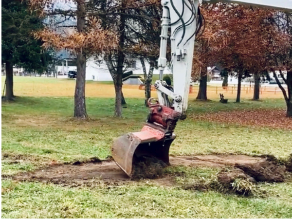
A talaj felső rétegének eltávolítása
