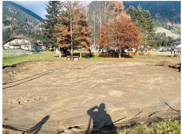
Az ágyazat előkészítése
